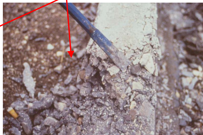
Degrado a seguito dell'interazione "calcestruzzo - sale disgelante"
