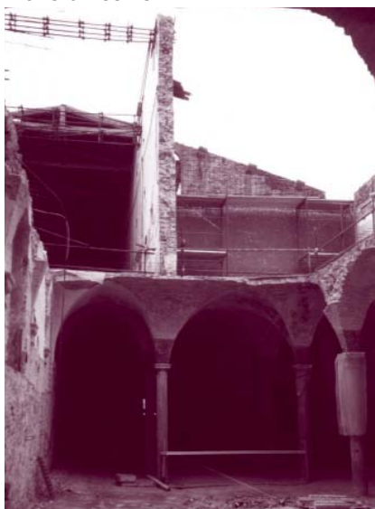
Foto dell'area collassata: sono visibili la snellezza dei piedritti e le dimensioni del muro in falso
