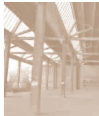
Fig. 15 - Vista interna della porzione del fabbricato con struttura in cemento armato
