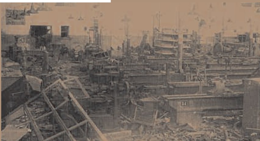
Fig. 7 - Il reparto macchine utensili dopo il sabotaggio nazista [3]
