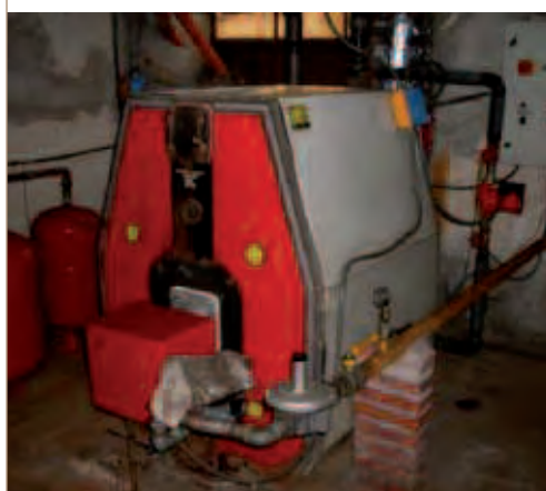
Fig. 11 - Intervento di rifacimento centrale termica con caldaia a condensazione prima e dopo l'intervento
