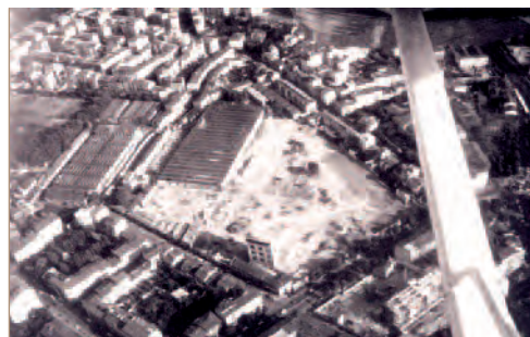
Fig. 9 - Foto aerea che mostra le demolizioni operate negli anni '80; è ancora in piedi la Torre telemetri. (Foto Arch. Moreno, Responsabile P.O. Valorizzazione complessi monumentali e supporto tecnico logistico, Comune di Firenze)
