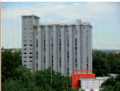
Fig. 13 - Silos in cemento riconvertiti in alloggi per studenti, Oslo (Norvegia)
