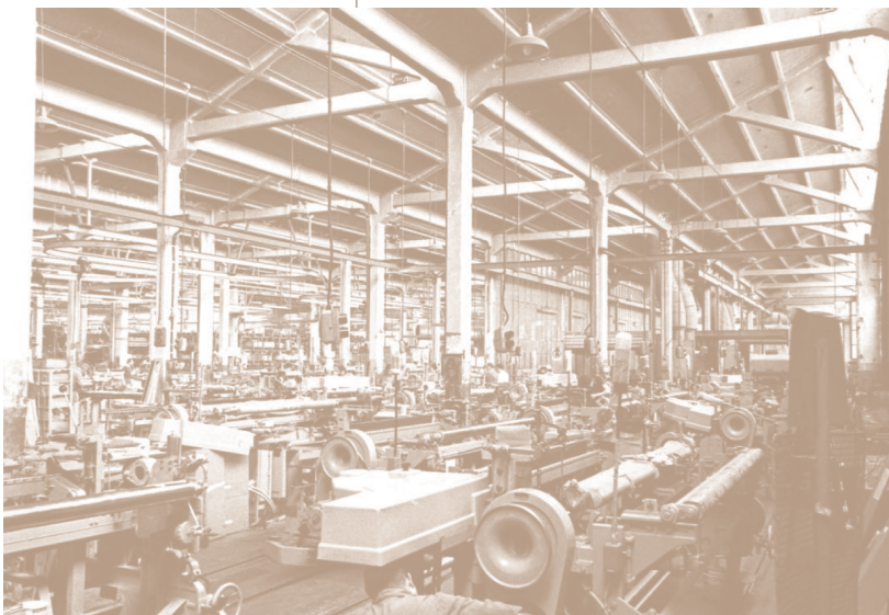
Fig. 5 - Foto dell'interno dello stabilimento con struttura in calcestruzzo armato (Archivio storico FLOG)
