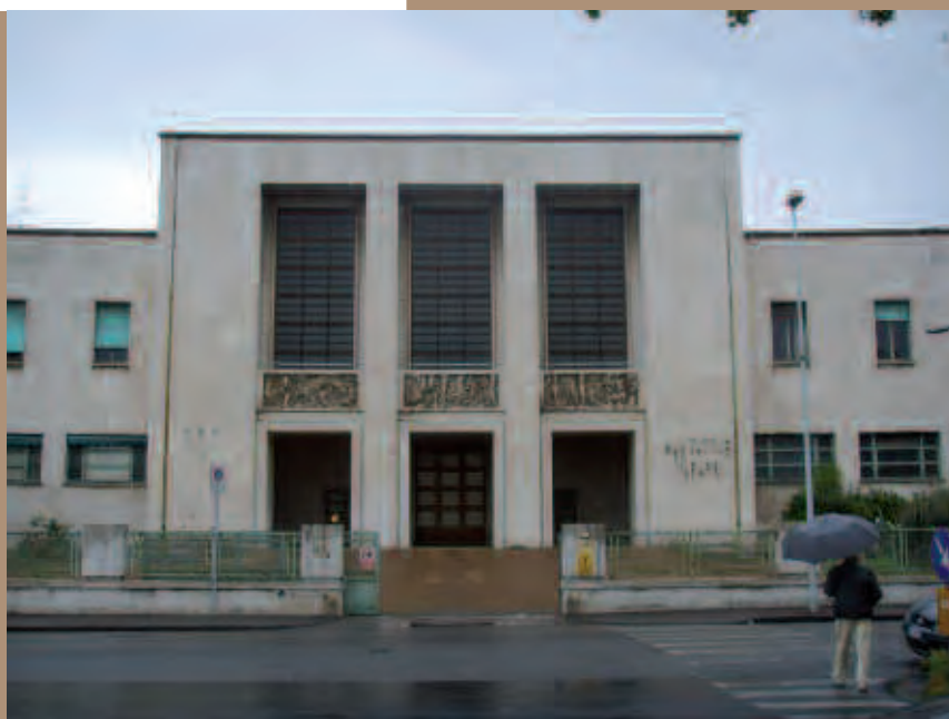
Fig. 5 - Ex-Manifattura Tabacchi, Cascine (FI)
