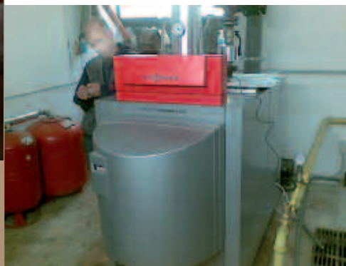
Fig. 11 - Intervento di rifacimento centrale termica con caldaia a condensazione prima e dopo l'intervento
