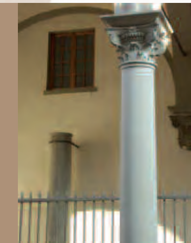
Fig. 10 - Gli effetti del degrado visibili su una colonna esterna con l'originale retrostante (originaria)
