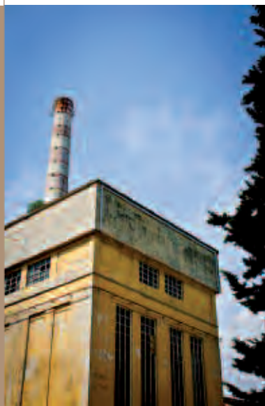
Fig. 3 - Area ex-FIAT, Novoli (FI) - Centrale termica
