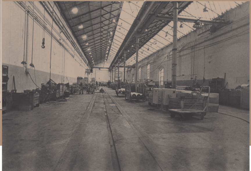
Fig. 4 - Foto interna dello stabilimento che mostra la struttura in ghisa (Archivio storico FLOG)
