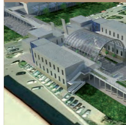
Fig. 19 - Vista della passerella di attraversamento di via Alderotti, le cui linee richiamano quelle della vicina pensilina metallica, in primo piano nella vista
