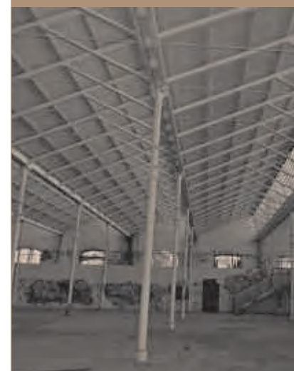
Fig. 16 - Vista interna della porzione di fabbricato con struttura in acciaio
