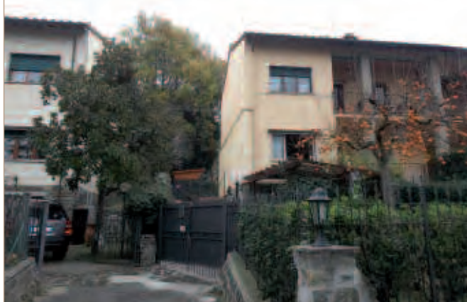
Fig. 12 - Intervento di cappotto termico su porzione di parete prima e dopo l'intervento.
