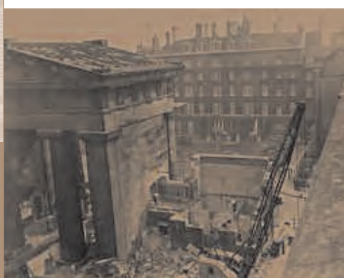
Fig. 1 - La demolizione del Euston Arch (Euston Station), Londra, 1962
