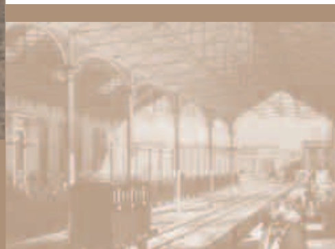
Fig. 2 - Copertura in ferro battuto della Euston Station, Londra, 1837
