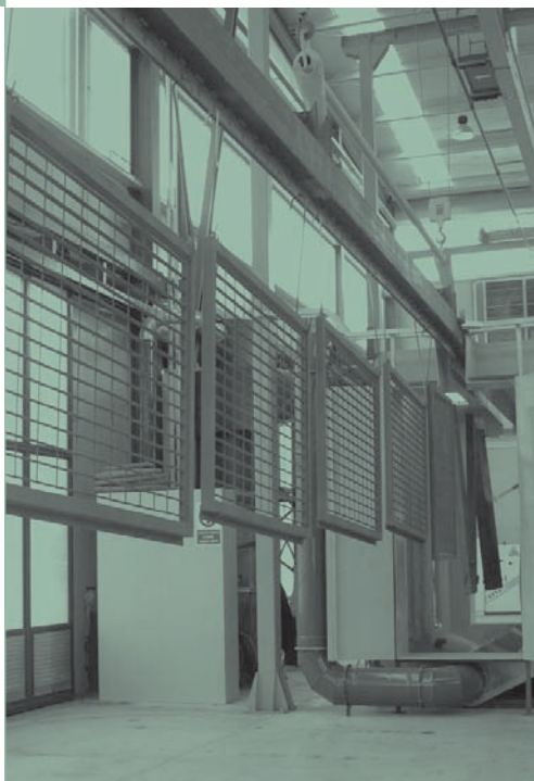
Impianto di lavorazione: particolare
