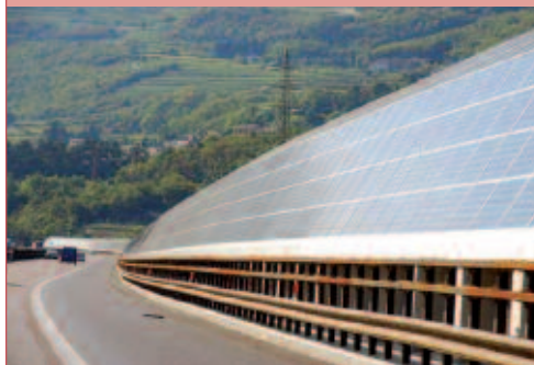
Barriere Acustiche Fotovoltaiche.
