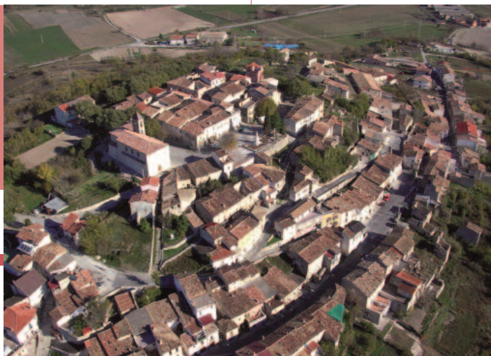
Fig. 1 - Vista aerea ante-sisma e post-sisma.
