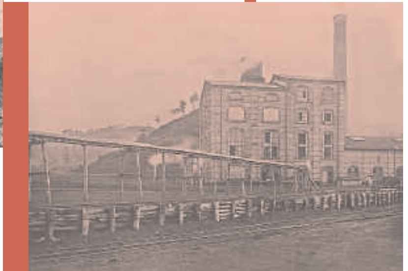
Fig. 4 - 1908 Impianto originale del bricchettificio (vista lato nord-est).
