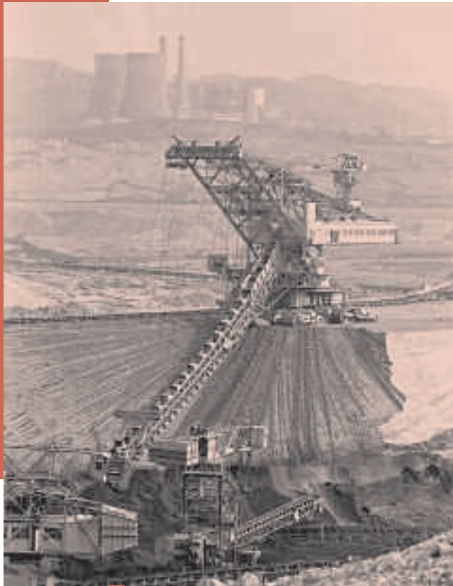
Fig. 3 - Escavatore terra e lignite, sullo sfondo la centrale di Santa Barbara*.
