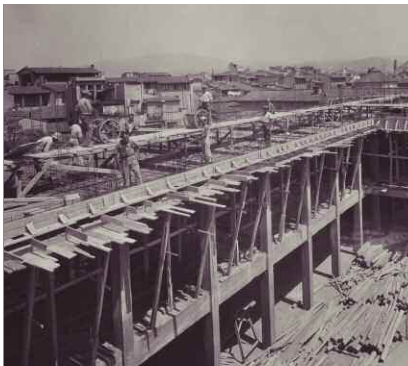
Fig. 10 - Vista generale del cantiere nel giugno 1955.
