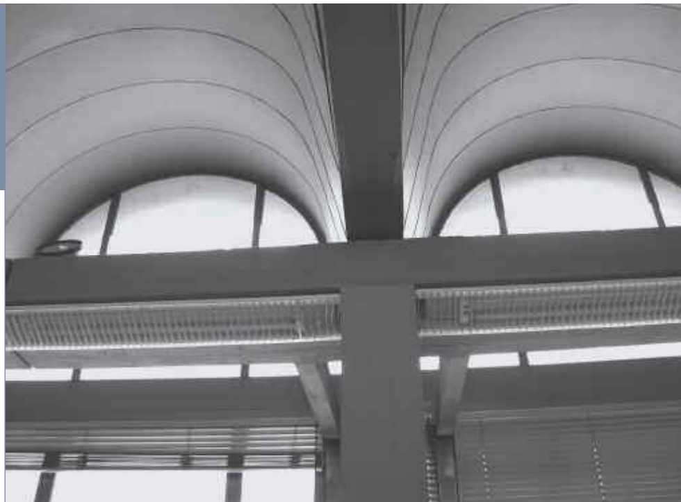
Fig. 6 - Le voltine della copertura (foto dell'autore).
