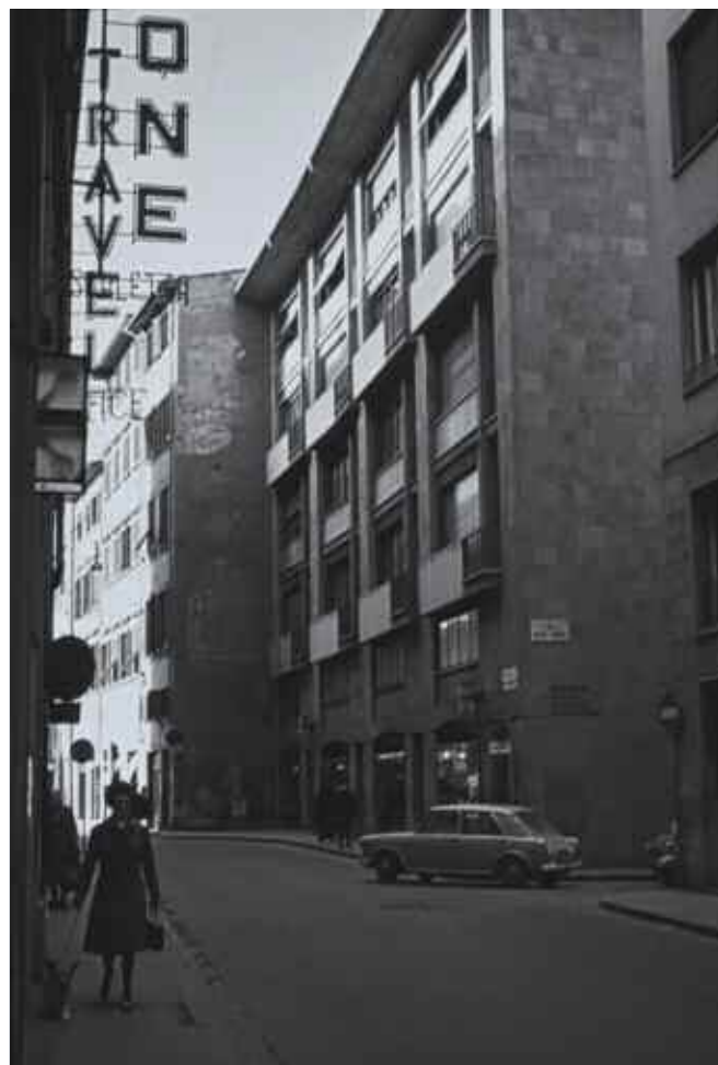
Fig. 2 - Edificio INA in via Guicciardini a Firenze (G. Michelucci) (foto dell'autore).
