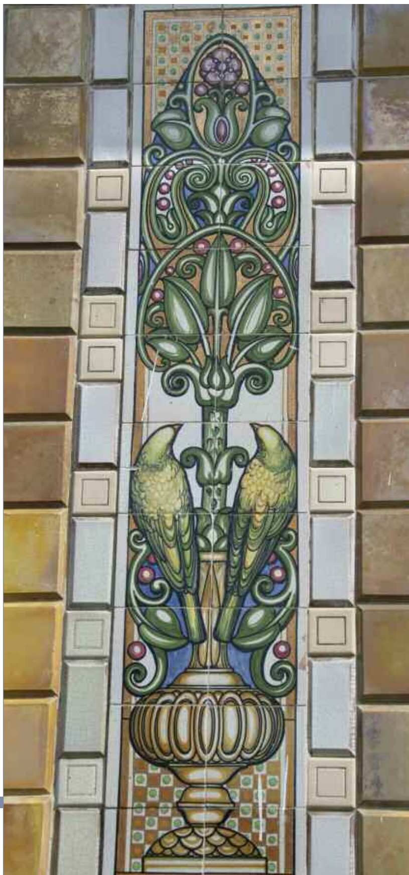
Fig. 3 - Villa Argentina, particolare del grande pannello ceramico.
