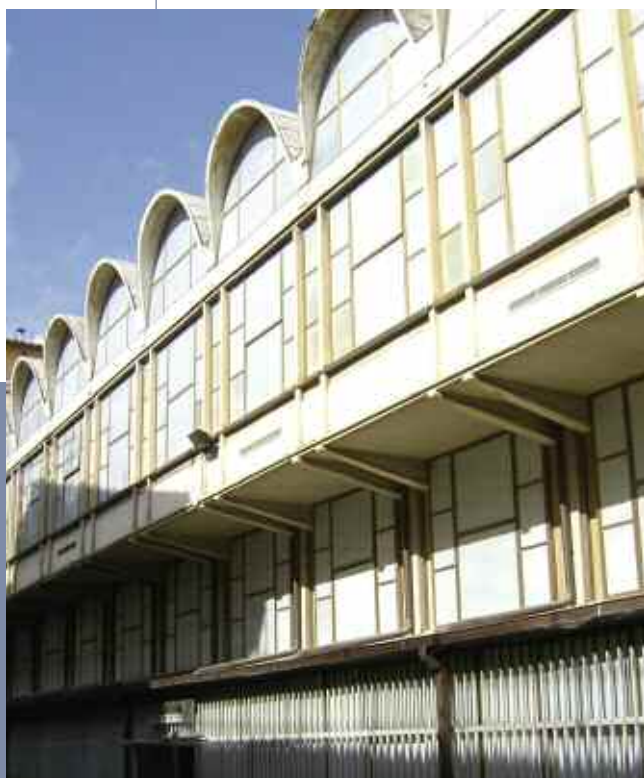
Fig. 9 - Vista del fronte strada interna (foto dell'autore).
