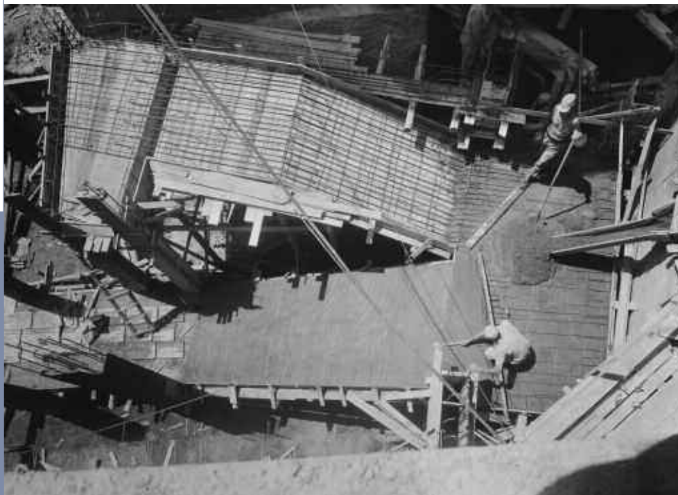
Fig. 12 - Strutture dello Salone, cantiere nel luglio 1955 (Archivio Studio ing. E. Berti, Arezzo).
