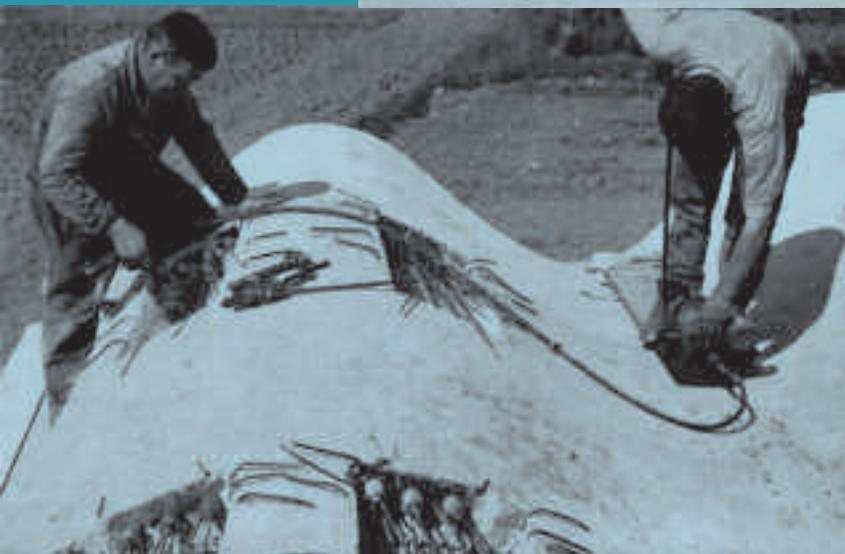
Le pensiline gemelle a copertura dei piani caricatori ferroviario e per autotreni, eseguite, uniche nel loro genere, in c.a. precompresso con sbalzo di 13,25 m, mediante una struttura ondulata ad andamento sinusoidale variabile, con uno spessore che passa dai 30 cm all'incastro ai 5 dell'estremità libera. Il primo tronco all'incastro, è stato gettato in opera, mentre i successivi 11 conci, prefabbricati a terra, sono stati saldati, dopo la tesatura.
