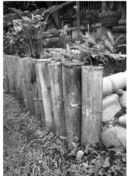
Uso del bambù senza precauzioni (destinato a danneggiamento per muffe, funghi, attacchi di insetti)
