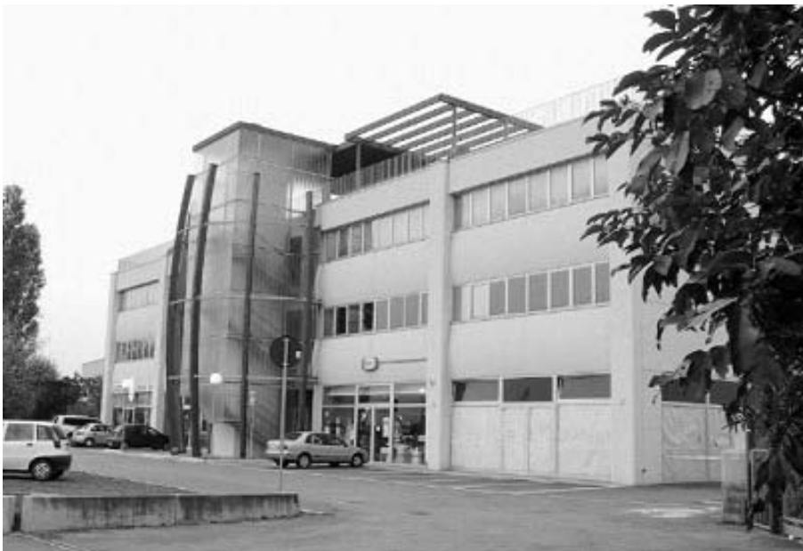
Tetti giardino su edifici produttivi (Via S. Silvestro - arch. Tabanelli)
