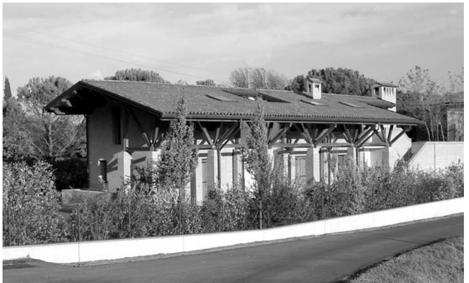
Portico in una casa di bioedilizia (arch. Ravagli)
