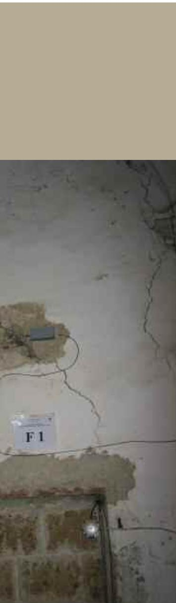
Figura 21. Sistema di monitoraggio - fessurimetro F1 (piano terra).
