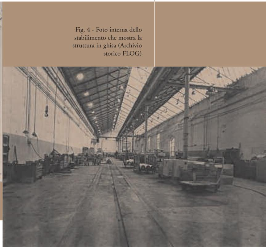
Fig. 4 - Foto interna dello stabilimento che mostra la struttura in ghisa (Archivio storico FLOG)
