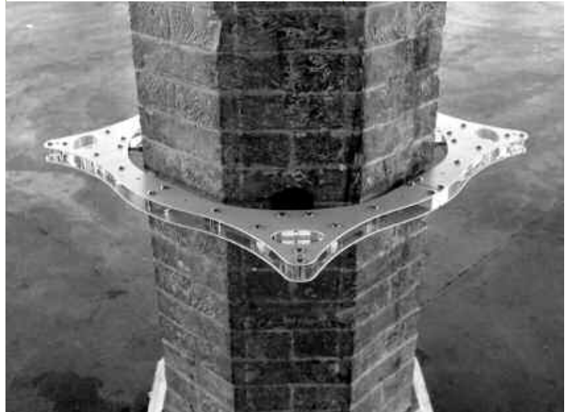
Fig. 8 - Coppie di sottili bracci in plexiglas, incernierati anch'essi agli anelli, impediscono poi con la loro leva qualsiasi rotazione dei singoli pannelli. In questo caso (date le dimensioni dei pannelli), è stato sufficiente montarne i braccetti nella sola zona alta.
