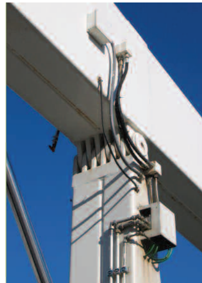
Fig. 8 - Gruppo elettrovalvole in prossimità dei cilindri.
