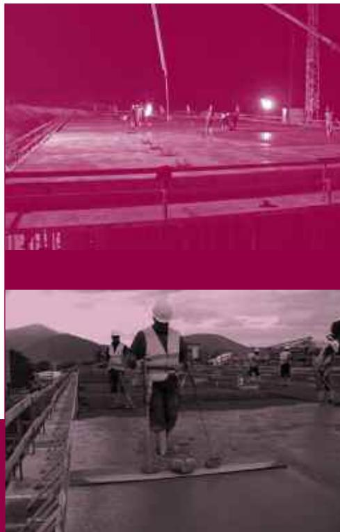
Fig. 5 - Alcune fasi realizzative delle piastre sismicamente isolate. Operazioni di getto e finitura superficiale dei calcestruzzi.
