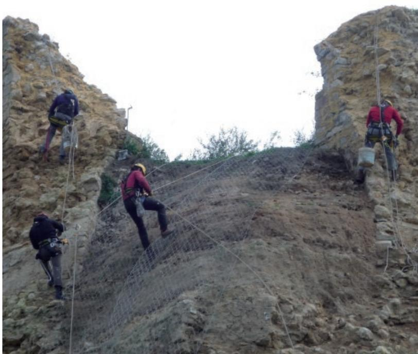
Foto 10 – Posa in opera di tirantature in acciaio.
