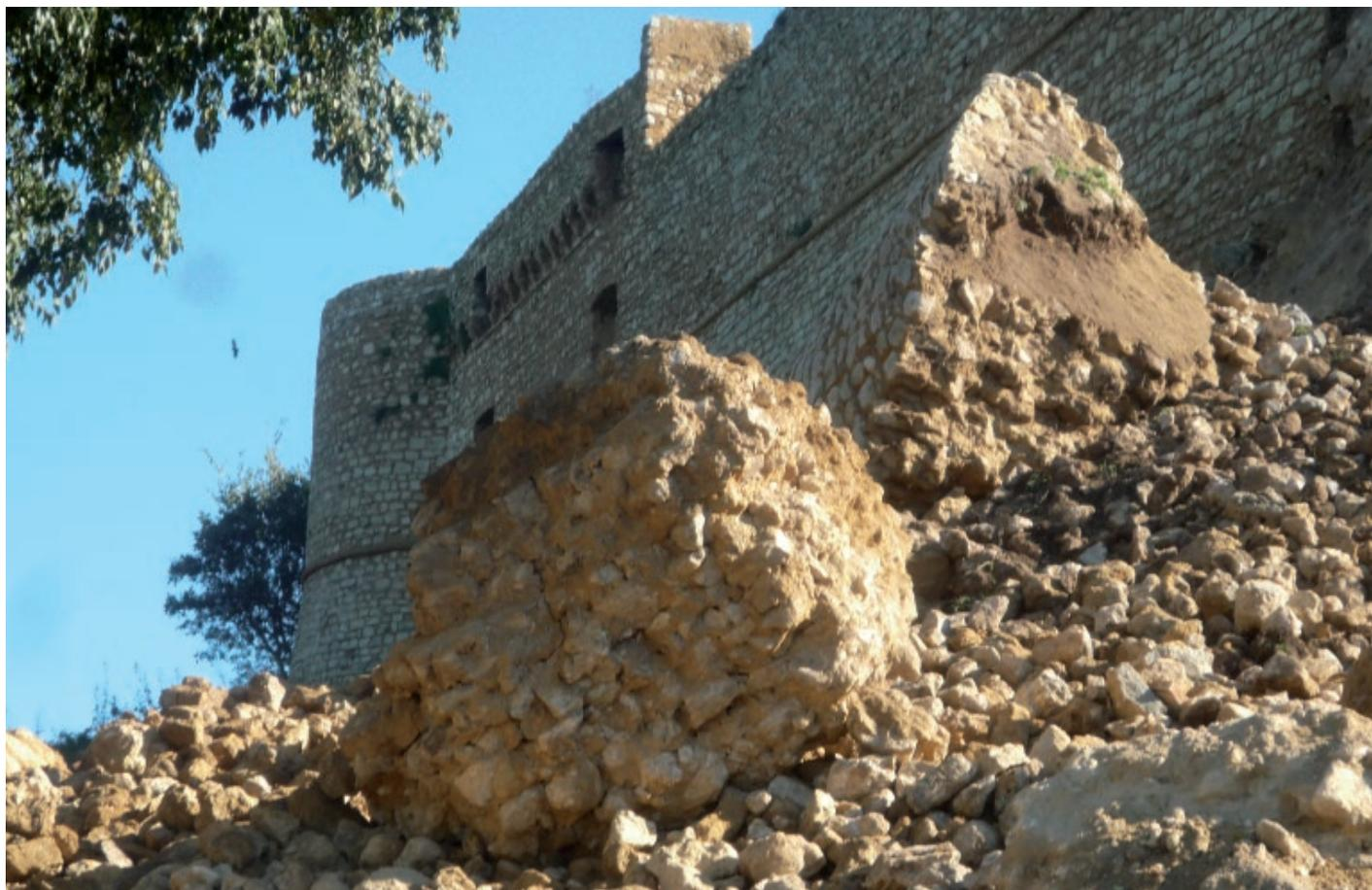
**Al termine delle operazioni di rimozione delle macerie è stato possibile rilevare l'entità e lo stato delle porzioni murarie residue**
