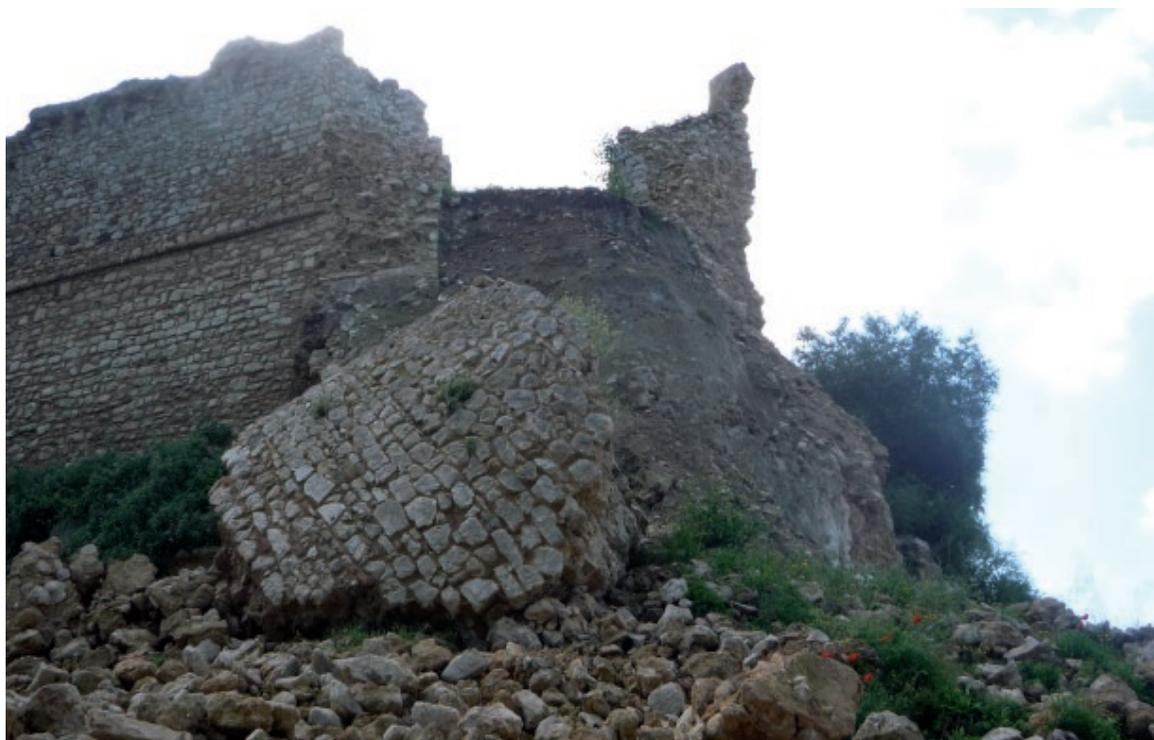
Foto 5 – Scivolamento della parte superiore del torrione.
