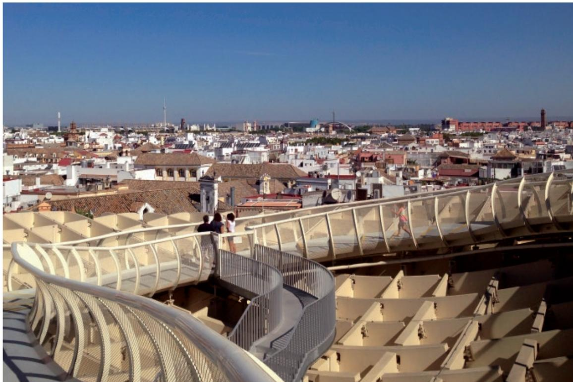
gli spessori tra i 68 ed i 311 mm. Gli elementi più grossi (16,5 x 3,5 x 0,14 m) sono nel tronco. Le unioni tra gli elementi di legno, oggetto di sperimentazioni specifiche, sono in acciaio fissato al legno con barre filettate fermate da resina epossidica oggetto di un successivo trattamento termico in camera secca, per aumentarne la funzionalità fino a temperature di 80 °C. Tutti i 35.000 fori per le barre filettate, di profondità tra i 65 e i 70 cm, sono stati eseguiti manualmente.
