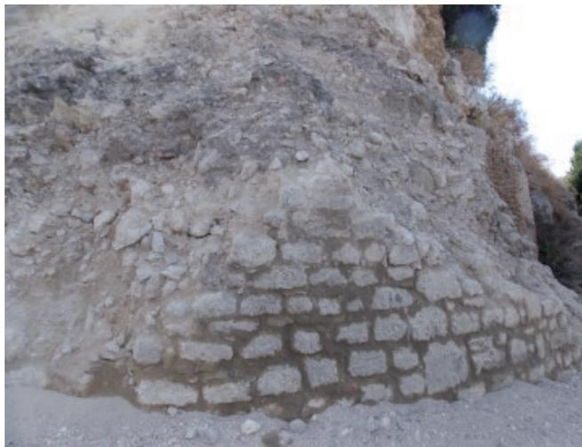
A seguito della pulizia del fronte del crollo e della rimozione delle macerie è stato possibile effettuare un rilievo tridimensionale con laser-scanner (tipo Riegl serie VZ) di tutta la parete esposta, con restituzione grafica sperimentale.
