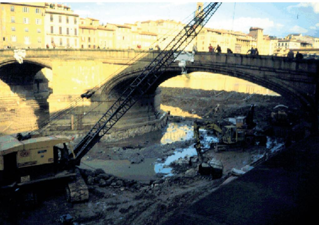
Abbassamento della platea del Ponte Santa Trinita (1977).
