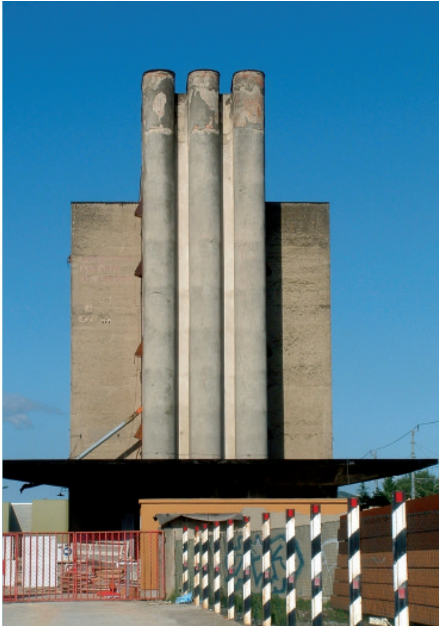
Vista del fronte principale del silos.
