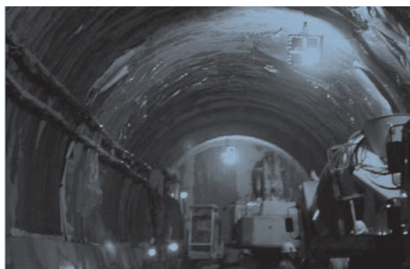
Fig. 3 - Riflettori combinati SAP-IM (galleria non grisutosa).
