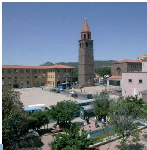
Fig. 17 - Vista della piazza prima dei lavori.
