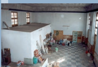
Fig. 10 - Foto dell'interno prima dei lavori.
