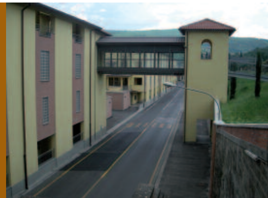
Fig. 11 - Foto dell'area Chelazzi parte ristrutturata – ponte di collegamento tra l'ex fabbrica e la stazione della ferrovia
