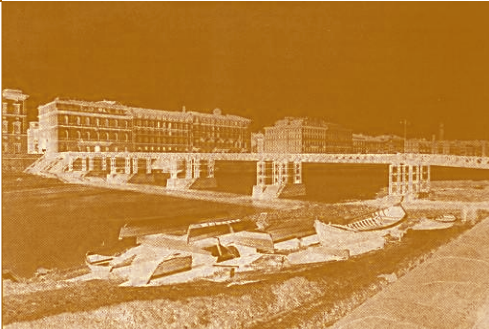
Fig. 3 - Il ponte provvisorio tipo Bailey a valle della pescaia di Santa Rosa sul fiume Arno nel 1950
