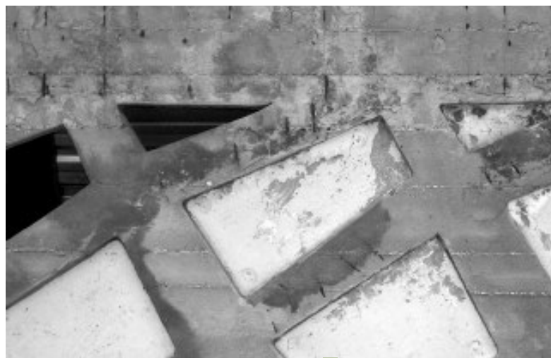
2. Intradosso di copertura
