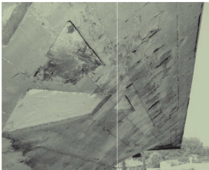
3. Intradosso di copertura (cordolo esterno)
