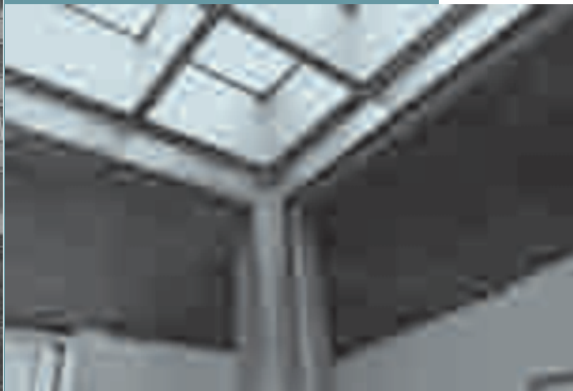
Fig. 20 – Dettaglio della copertura dell'atrio dell'auditorium
