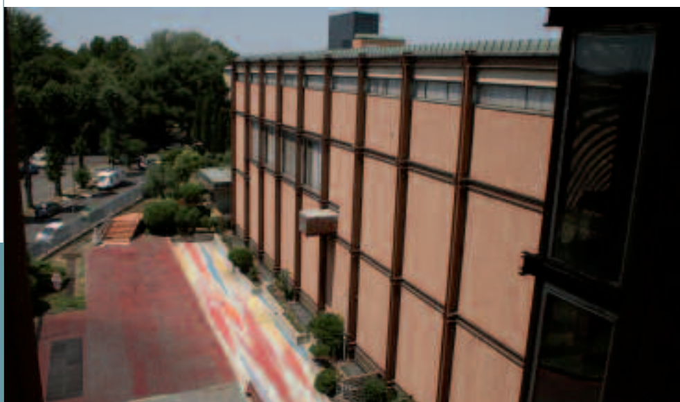
Fig. 25 – Vista del prospetto sud della Zona radio
