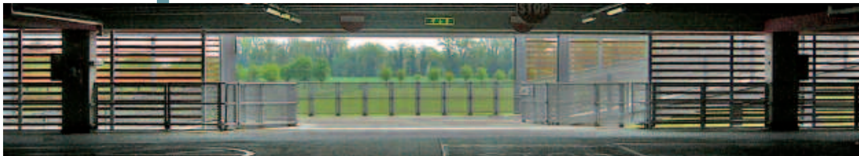
Fig. 28 - Vista ingresso carrabile del primo livello del parcheggio multipiano
