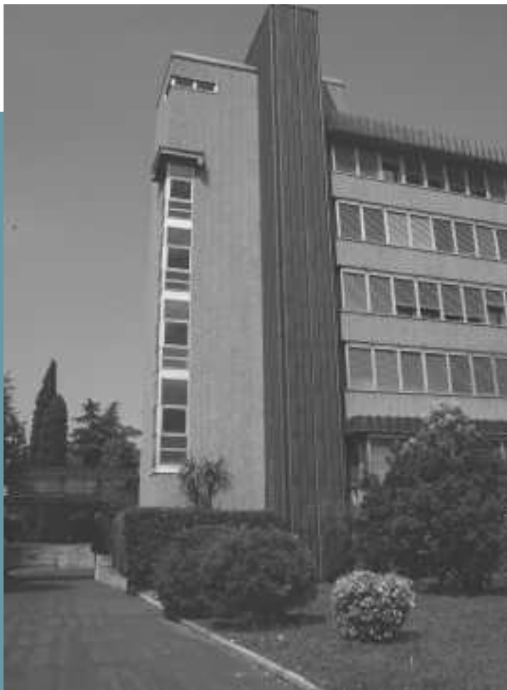
Fig. 18 – Vista del prospetto est della Zona uffici in corrispondenza di un vano scala
