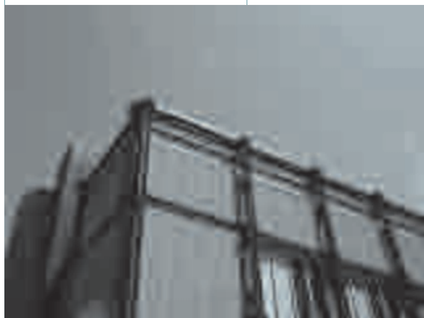
Fig. 27 – Dettaglio del prospetto sud della Zona radio
