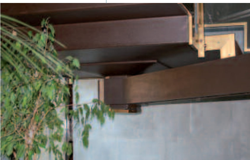
Fig. 14 – Dettaglio della scala all'interno dell'atrio principale
