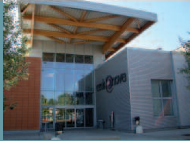
Fig. 19 - Nuovo ingresso ad ovest
