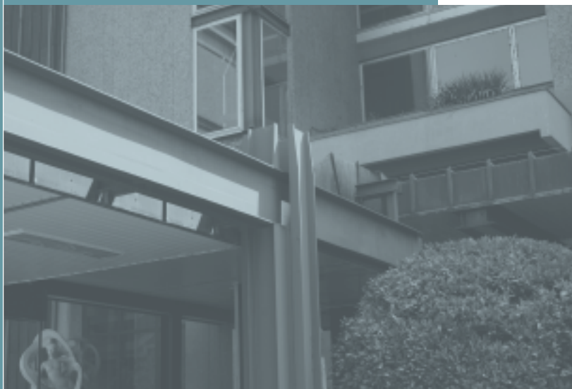
Fig. 21 – Dettaglio della tettoia che protegge l'ingresso dell'atrio principale
