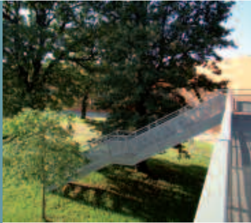
Fig. 29 - Vista di dettaglio della uscita di sicurezza del "giardino delle querce"
