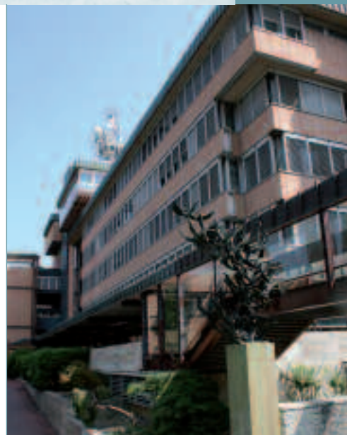
Fig. 9 – Vista della passerella sul fronte ovest
