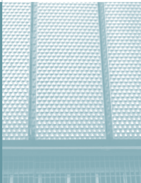
Fig. 29 – Dettaglio del rivestimento in acciaio smaltato della parete esterna sul fronte nord della Zona radio
