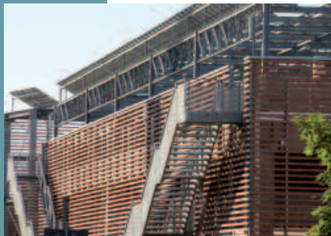
Fig. 26 - Vista lato nord parcheggio multipiano
