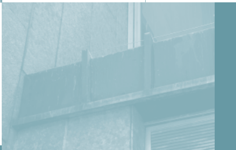
Fig. 30 – Dettaglio di un coronamento in rame
