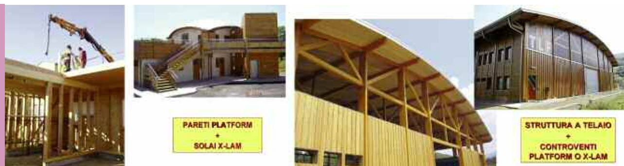
Figura 14. Edifici con pareti tipo platform e solai in pannelli massicci incollati (a sx) – Strutture a telaio e sistema di controventamento a pannelli tipo platform oppure Xlam (a dx).
