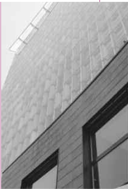
Figure 26-27-28. GSW Haus, funzionamento del sistema schermante.
