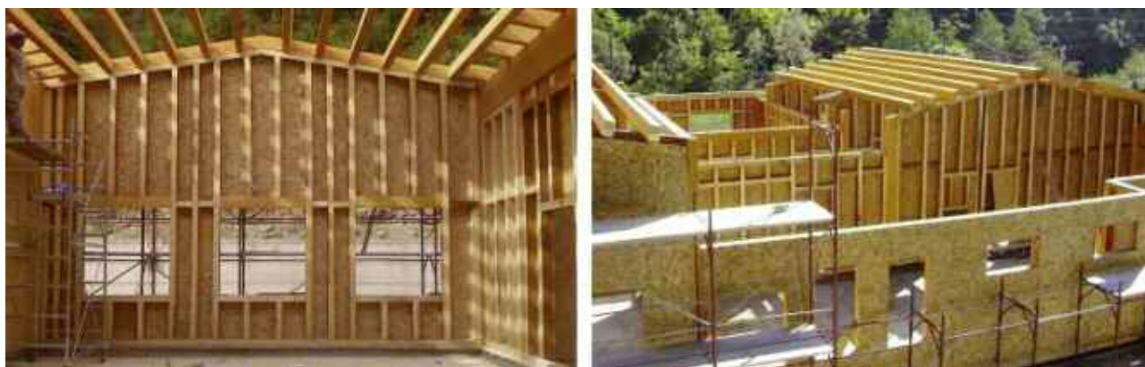
Figura 8. Sistema platform-frame.
