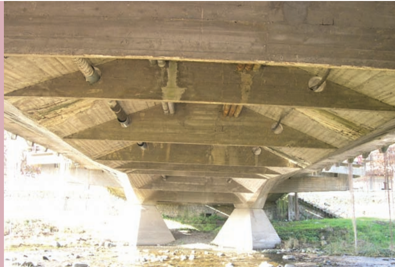
Fig. 9 - Vista sotto impalcato del ponte Europa
