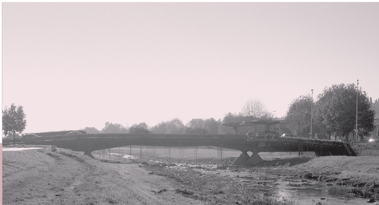
Fig. 6 - Vista prospettica del ponte Europa
