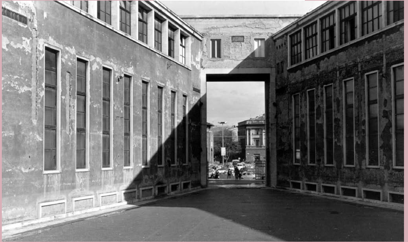
Fig. 8 - Scorcio dell'esterno dal cortile
