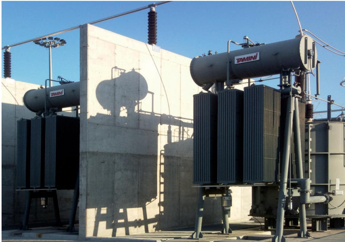
La magnetostrizione con macchine collegate alla rete produce un rumore continuo e costante. L'emissione rumorosa è differente a seconda della tipologia di trasformatore, ma è quasi sempre ben caratterizzata, in frequenza, da componenti principali nelle bande di terzi di ottava con centro banda 100, 200, 315 Hz.
