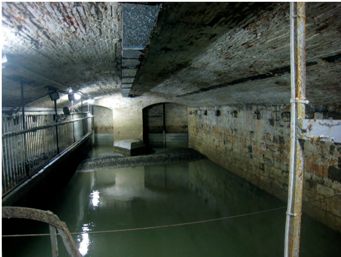
Fig. 6 e 7 - Canale Macinante in corrispondenza delle prese della Pescaia Santa Rosa
