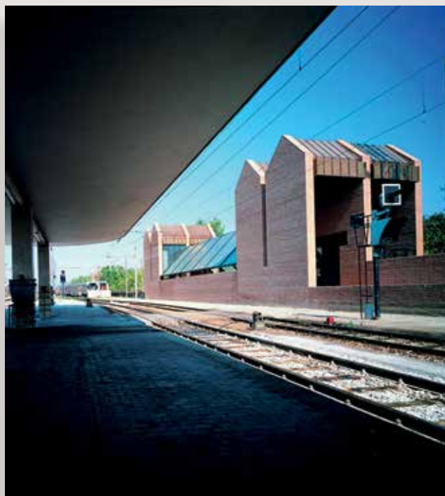
Fig. 4 14 - Nuovo accesso alla Stazione di Santa Maria Novella a Firenze ieri (Gae Aulenti e B. Ballestrero - 1989-90)
