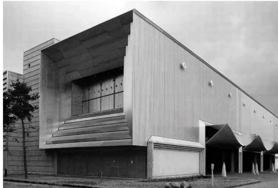
originariamente a pianta poligonale, viene modificato in circolare con un ampio patio interno, sormontato da un grande lucernario a cupola. Le strutture sono in cemento armato prefabbricato su misura.
