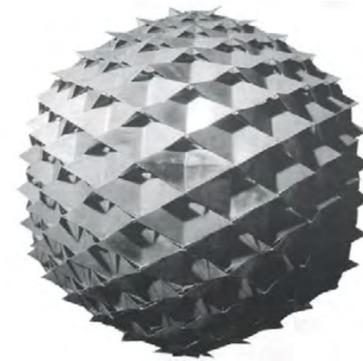
progetto sono combinati la padronanza tecnica dei nodi articolati e la forma geometrica. Questa volta egli usa una sola cupola geodetica triangolare, ma suddivisa in sezioni pentagonali ed esagonali, coperte da lastre, che danno un'immagine molto diversa da quella dei triangoli delle sue precedenti proposte. Progetta anche il sistema di sedute pieghevoli, ampliando e correggendo un precedente prototipo.
