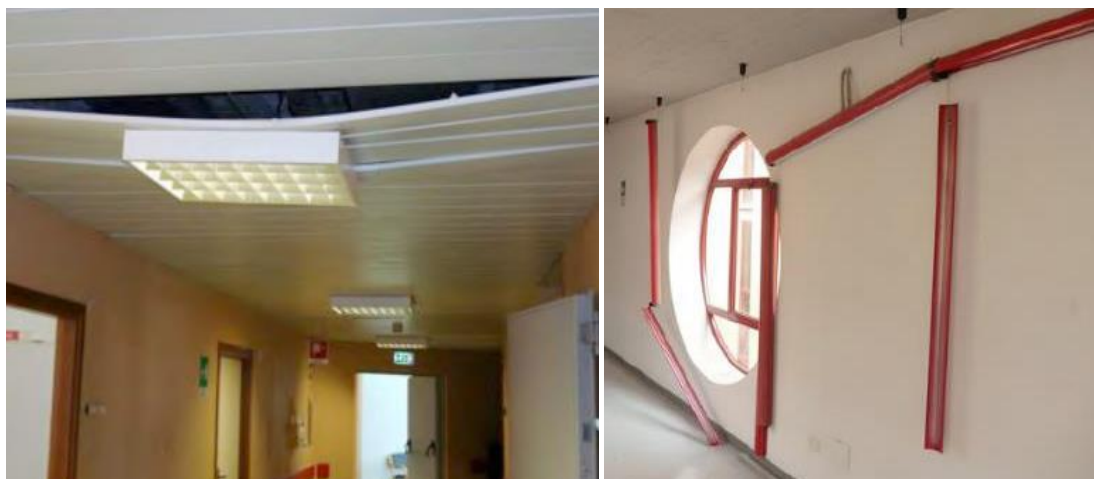
FIG. 1 - Danni su elementi di impianto
