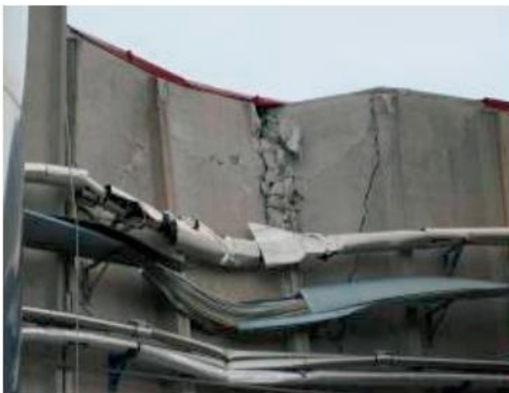
FIG.5 – Criticità locali dovute all'interazione con altri elementi, esempio il martellamento dell'involucro di un silos contro parete perimetrale (Terremoto L'Aquila 2009)
