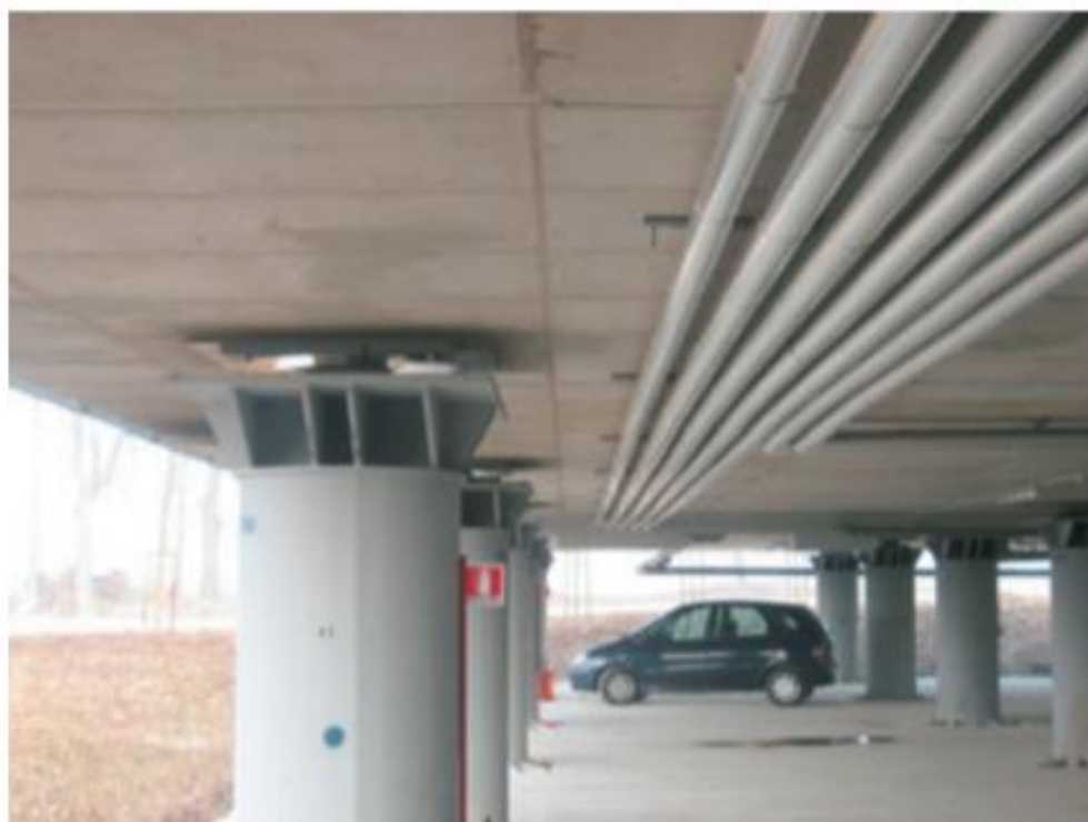
FIG.9 – Esempio distanza di sicurezza tra tubi e pilastri per evitare che entrino in contatto durante il sisma (Terremoto l'Aquila 2009) .
