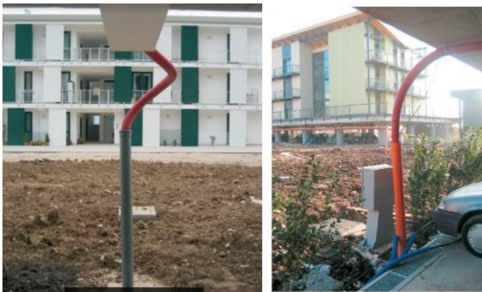
FIG.8 – esempio di disconnessione di cavidotti ( Terremoto L'Aquila 2009)
