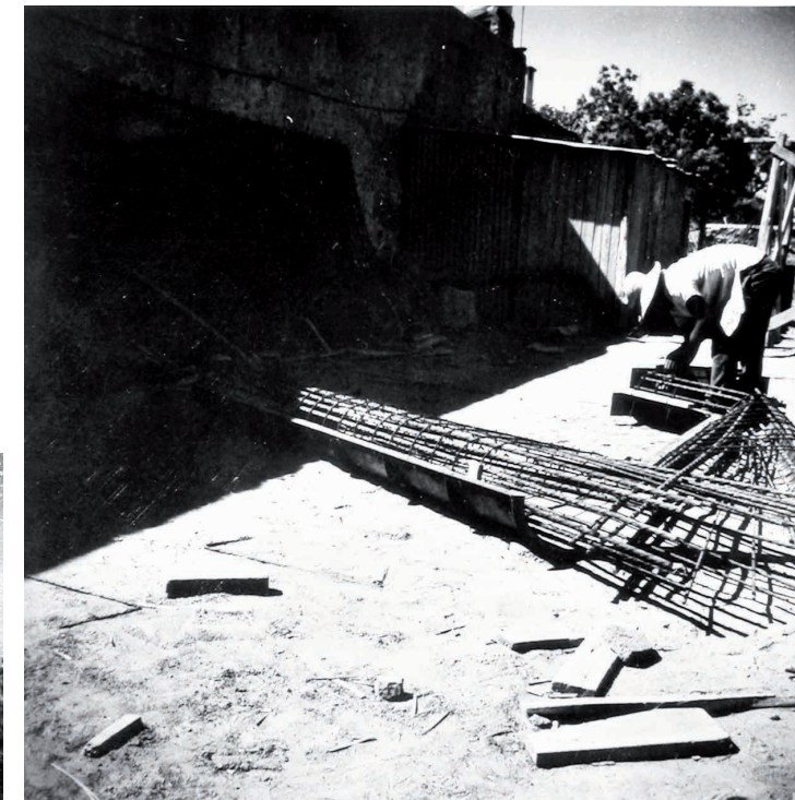
Le armature dei pilastri a V del Piano terra e delle travi di fondazione
