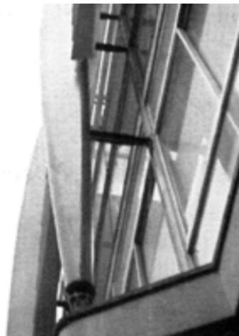
al quale fa capo l'orditura di sostegno delle intelaiature porta cristalli realizzate in lega di alluminio (v. fig. 7). Questi traversi sono in due parti con un collegamento a flangia a fori ovalizzati in corrispondenza della loro sezione mediana in modo da rendere il ritto esterno a guscio, indipendente dalla vetrata agli effetti delle dilatazioni termiche (v. fig. 5).
