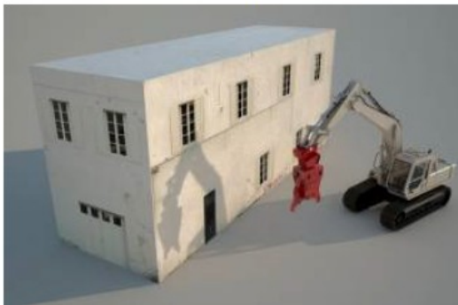
Approntamento e demolizione muratura (messa a nudo telaio)
