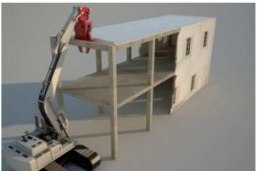
Frantumazione trave di testa e sfondamento solaio
