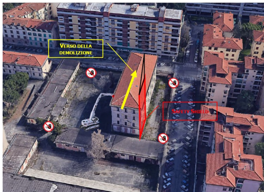
Sedime di inizio demolizione
