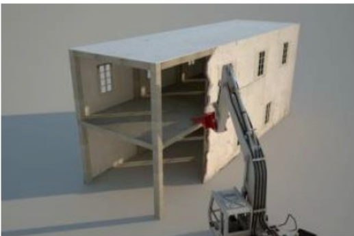
Demolizione muratura (messa a nudo telaio)
