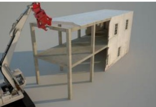
Frantumazione trave di testa e sfondamento solaio
